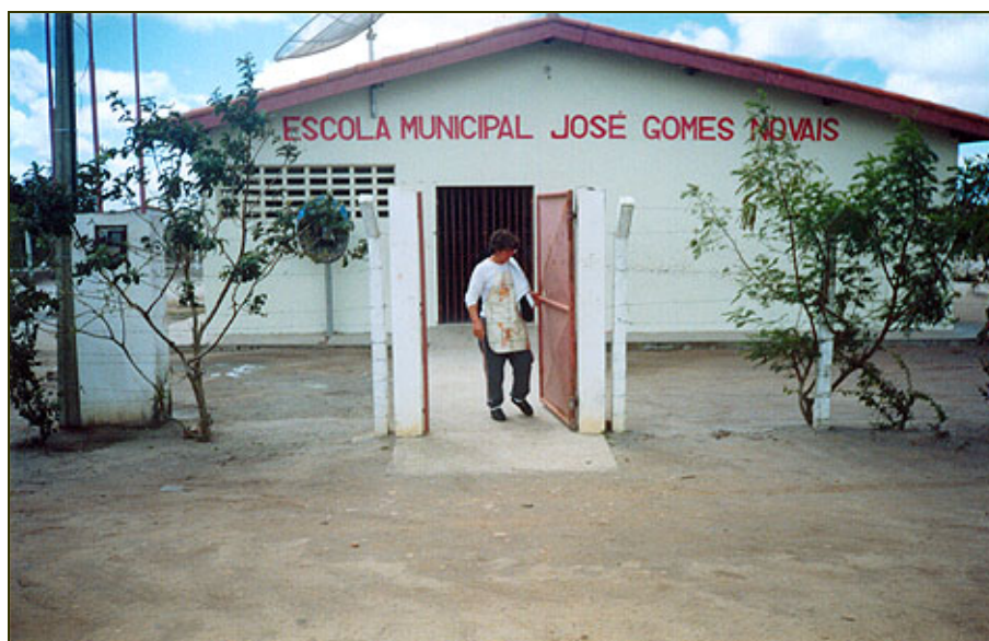
Foto 4 – Fachada da Escola José Gomes Novais
